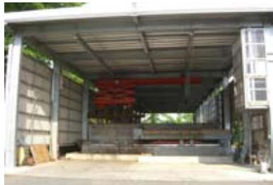
懸垂型クレーン式コンポストユニットは、堆肥化醗酵の際の「水分調整」や、堆積エリアへの「搬送」、醗酵促進のための「切返し<sup>※4</sup>」作業を無人で行っている。従来の堆積式で時間を要していたショベルローダー<sup>※5</sup>での切返し作業がなくなり、大幅な省力化に繋がる。
