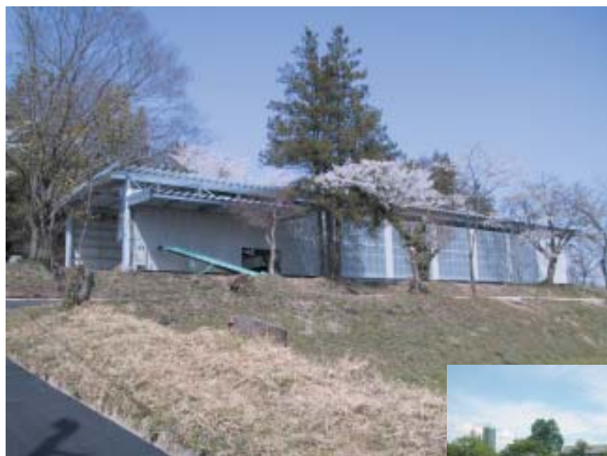
広島県立畜産技術センター堆肥化施設
