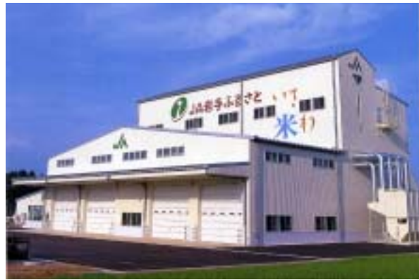
JA岩手ふるさと胆沢(いさわ)南部地区ライスセンター
